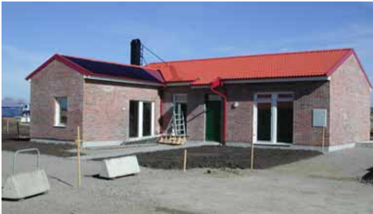
Fotomontage med takintegrerad plan solfångare typ Vitosol 100
